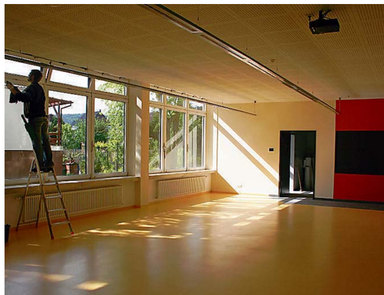
An der ERS Rehlingen entsteht die neue Schulmensa. FOTO: ROI
